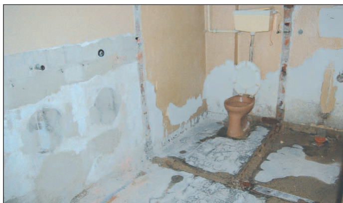
Modernizáciou prešli aj sociálne zariadenia.
