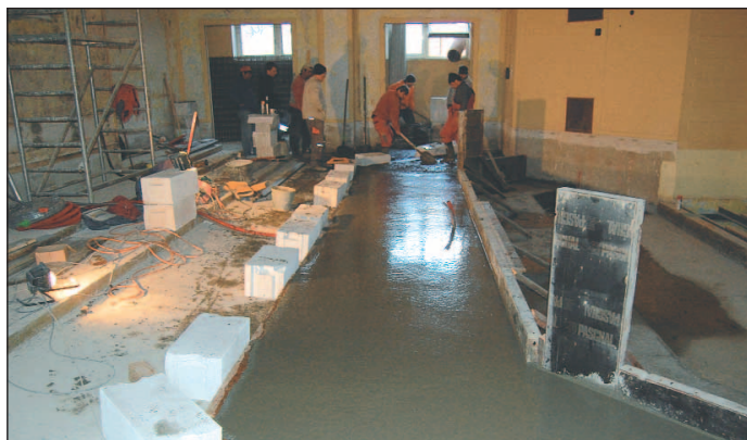
Jednotlivé stupne hľadiska museli byť vyvýšené, aby bol výhľad na kinoplátno čo najlepší.
