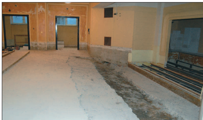
Sedadlá boli demontované a odkryli sa nedostatky na kanalizácii, kúrení a rozvodoch. To všetko čakalo ukryté od roku 1964, kedy bol dom kultúry sprístupnený verejnosti.
